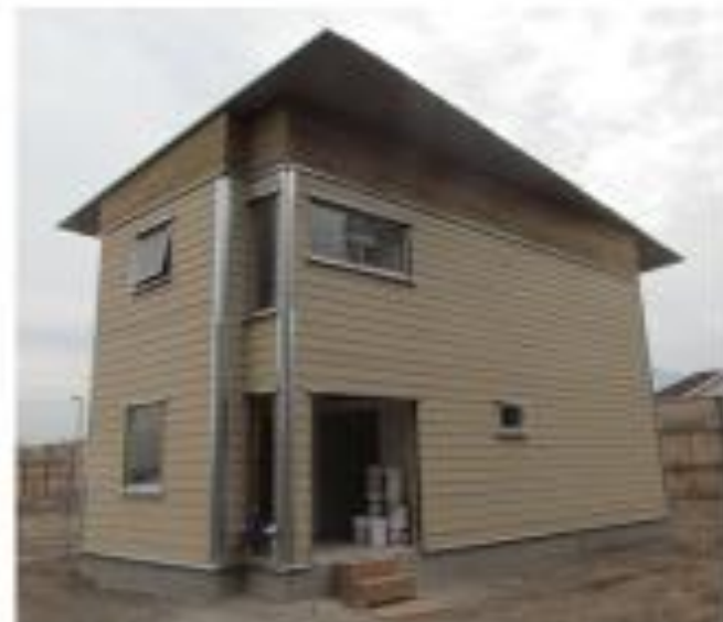
Viviendas de 98m 2 sistema muro ventilado, Ciudad del Sol (Puente Alto), 2011, (ahorro en calefacción en un 60%) Fondef II (2012)
